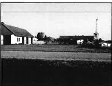
Figuur 6. Open houten kapschuur.
