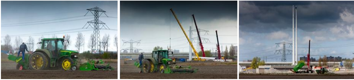
Foto 2 Het bouwen van een mast.
