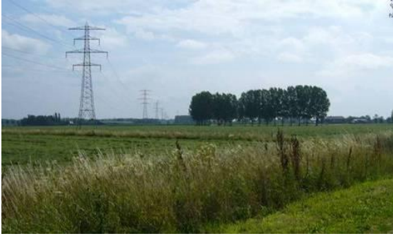
Foto 3 De huidige hoogspanningslijn loopt tamelijk autonoom door het landschap en passeert en doorsnijdt daarbij de beplantingsstructuren. De erfbeplanting is nadrukkelijk aanwezig in de ruimte.
