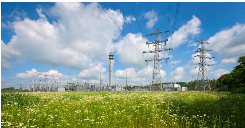
Foto 8: Hoogspanningsverbindingen station Doetinchem 380 kV
