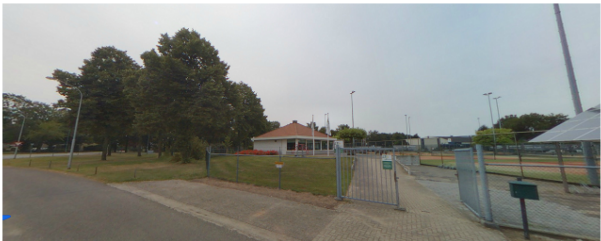
Zuidzijde, kantine en kleedkamers tennisvereniging IJsselweide
