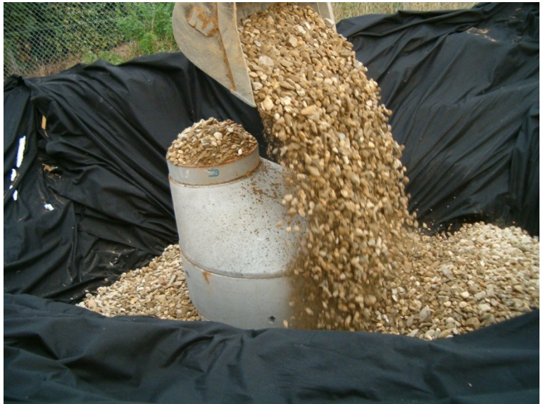
Aanleg van een infiltratievoorziening met grind
