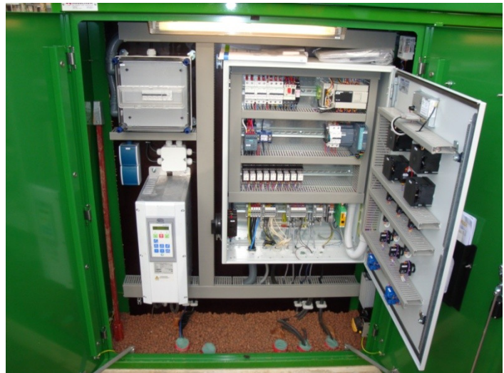
Besturingskast gemaal
