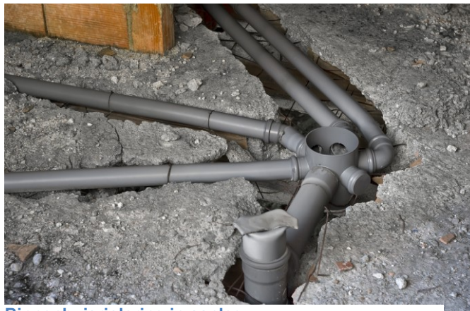
Binnenhuisriolering in aanleg
