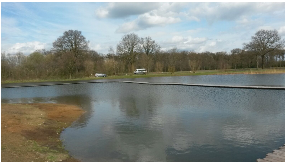
Retentievijver met knuppelpad bij het Hofshuus
