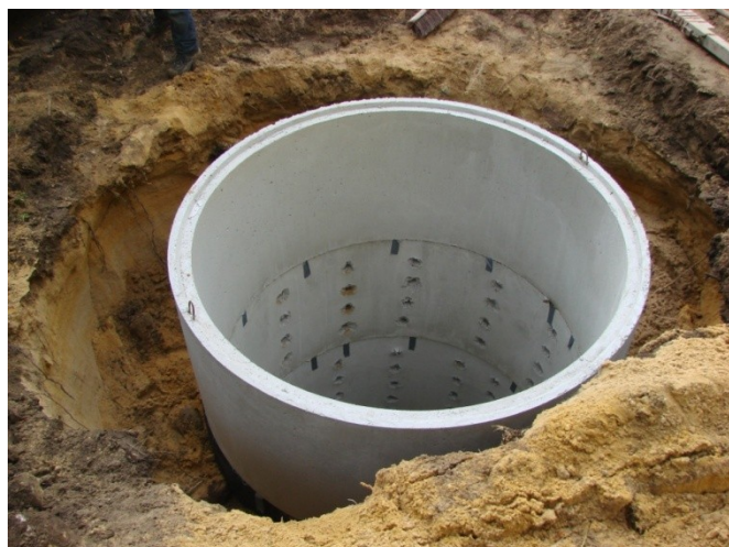
Bovenaanzicht van een infiltratievoorziening in aanleg
