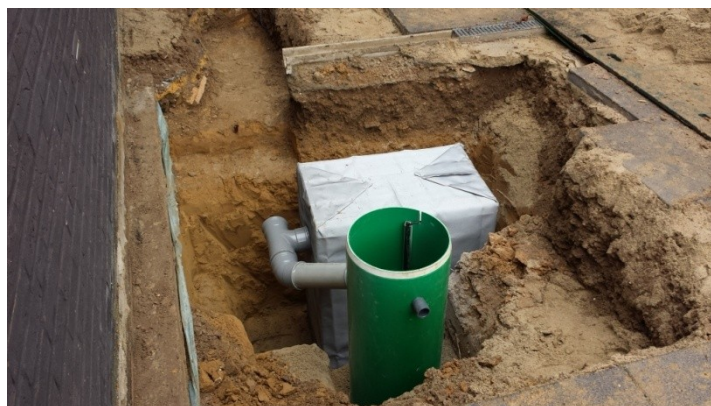
Infiltratievoorziening met zandvang (groen)
