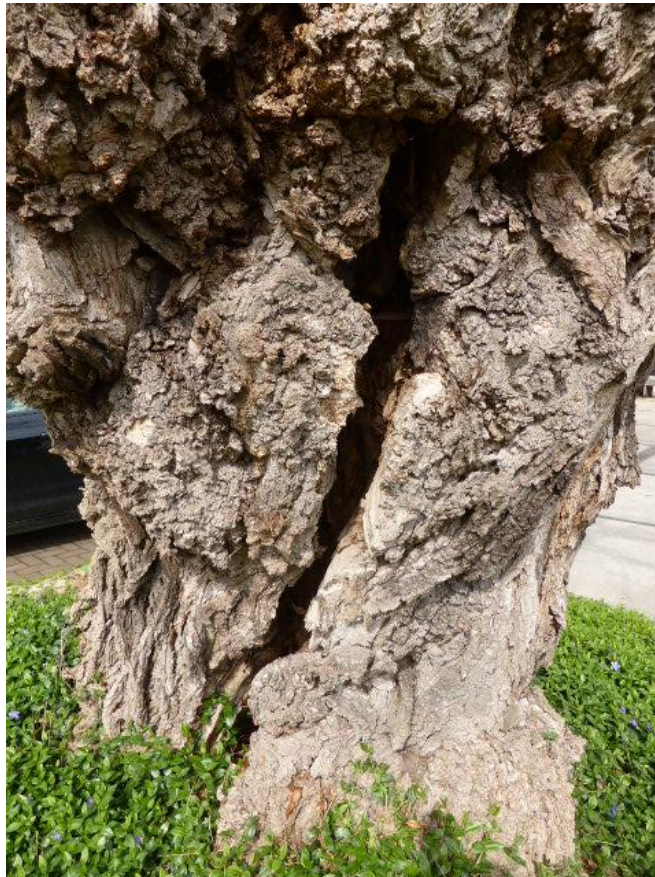
Foto 2, Robinia 1 heeft een forse scheur vanaf het maaiveld tot één meter onder de vergroeiing
