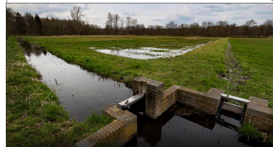
Fig. 104 Infiltratie beekwater via opgeleide waterloop
