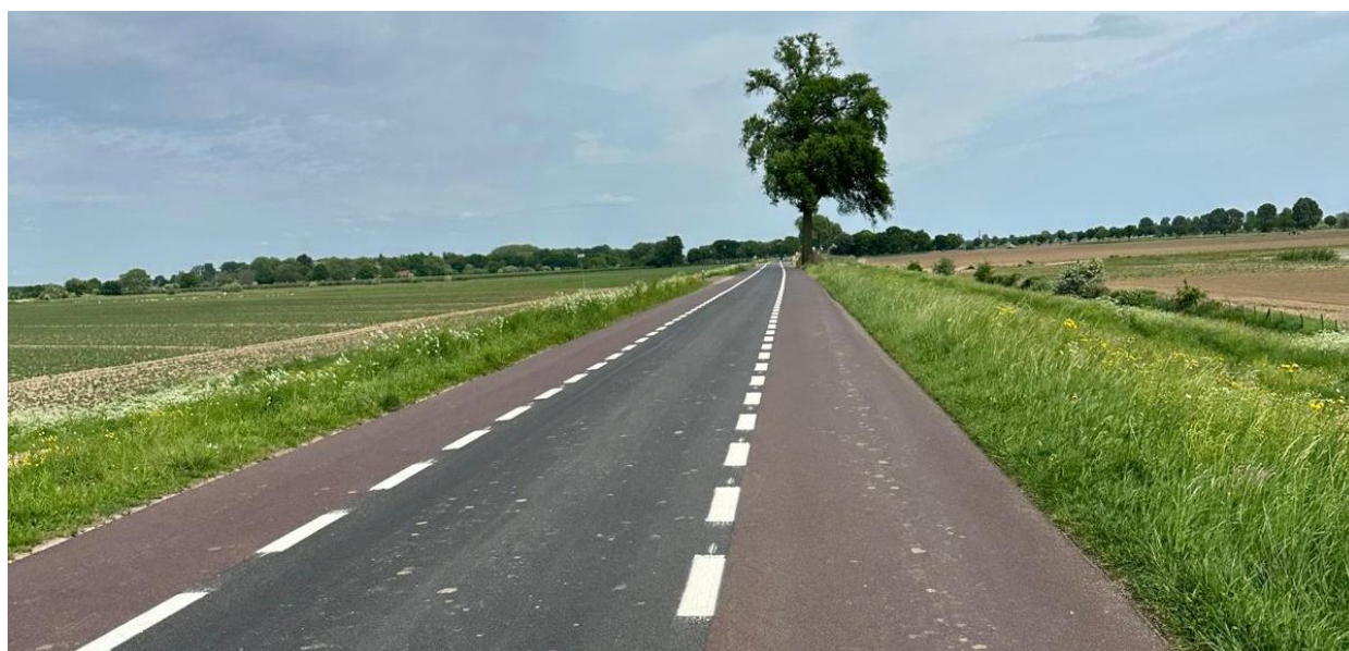
Figuur 3-1 Voorbeeld gemend profiel met fietsstroken
