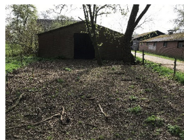
foto 6 - ter plaatse van boring 02
