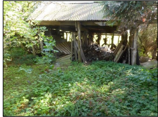
Een overkapping met opslag van materialen te midden van de houtopstand.
