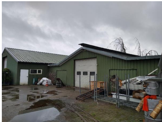
Foto: Schuur met asbestdak
