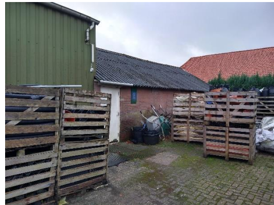
Foto: Vervangen asbestdak en opslag materiaal
