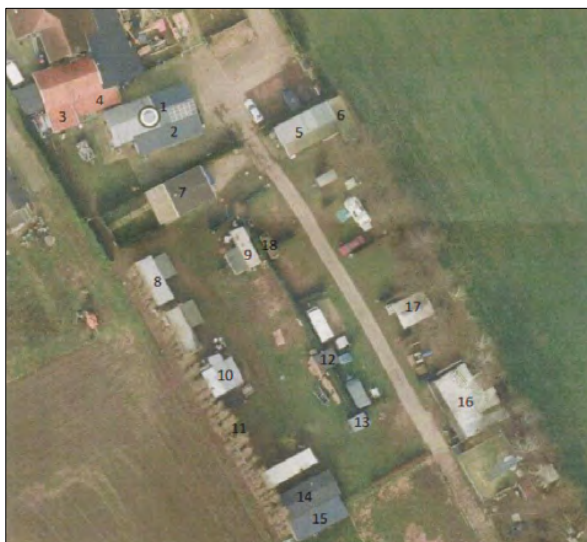
Gebouwen van camping Halfweg waarvan een deel behouden blijft en een deel wordt gesloopt (bron: ROlin Advies Achterhoek).
