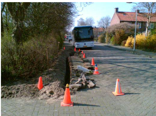
onderhoud kabels en leidingen
