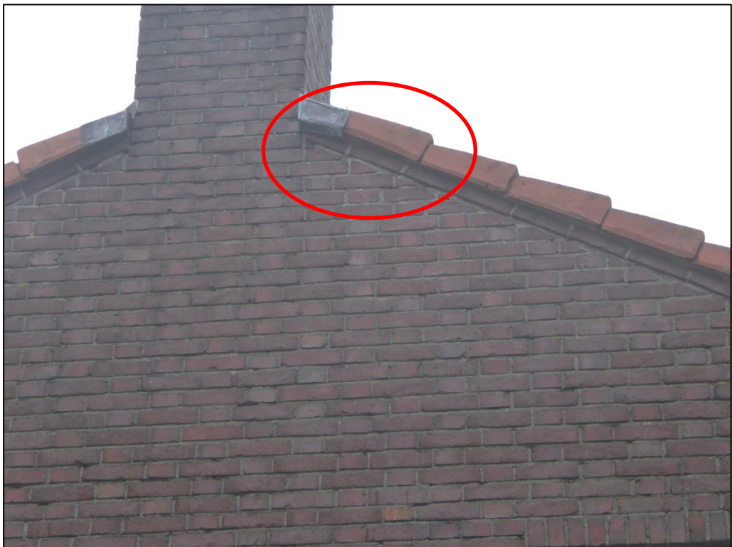
Ruimte waar vleermuizen naar binnen kunnen kruipen en zo het dakbeschot kunnen bereiken.
