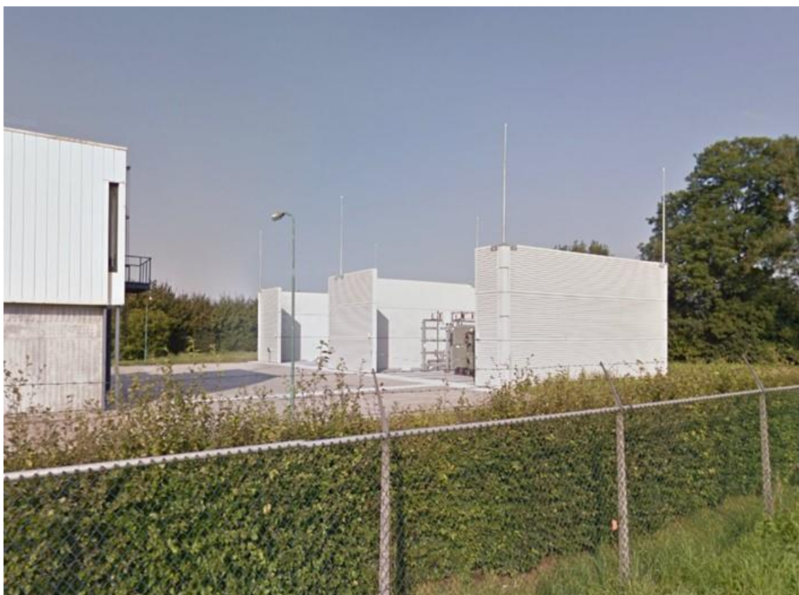
afbeelding 3: aanzicht plangebied vanaf zuidzijde met de twee transformatorruimten waarin nu de 40 MVA transformatoren staan (bron: google streetview)
