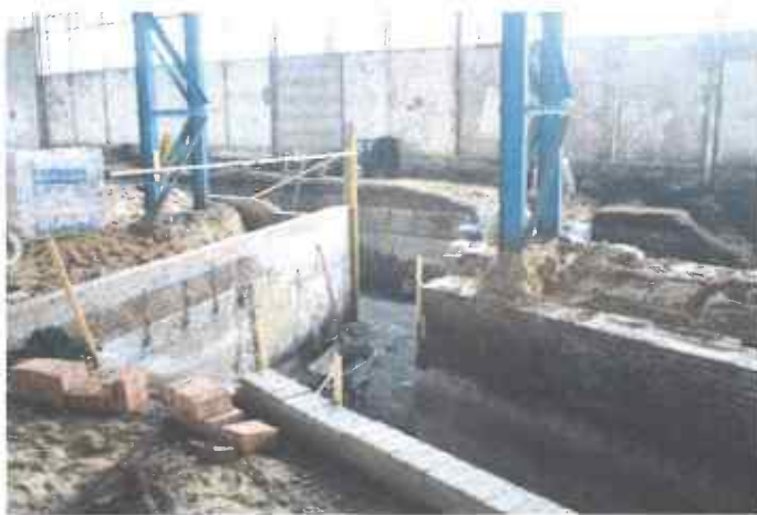
Opgravingen in de SSP-hal, april 2011
