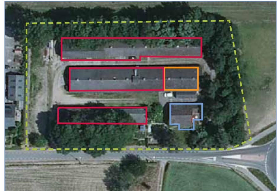
Luchtfoto met het erf. De groene stippellijn geeft globaal de erfgrans aan. De rood omlijnde schuren en stallen worden gesloopt, de in blauw omlijnde woning blijft behouden, evenals het trafohuisje vooraan op het erf. De oranje omlijnde stal wordt verbouwd tot bijgebouw.
