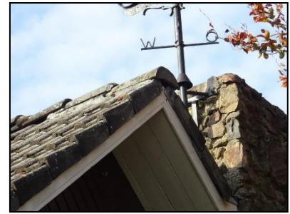
Figuur 17. Openingen in de nokvorst en tussen de kantpannen bieden toegang tot ruimten onder dakpannen en de overstek.
