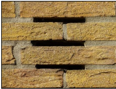
Figuur 15. Ventilatieopeningen die toegang bieden tot een open spouwmuur.
