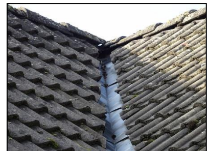
Figuur 12. Via de hoek in het dak is er toegang tot ruimten onder de dakpannen, voornamelijk onder de nok.
