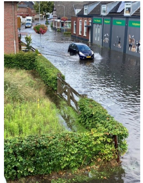
Figuur 3: ondergelopen weg in Varsseveld
