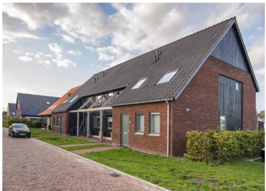
Schuurwoningen op het erf
