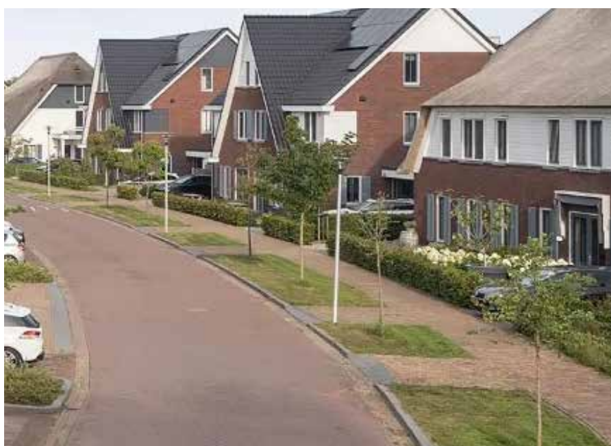
Nuanceverschillen in kleurgebruik in het straatprofiel (rijbaan vs trottoir)
