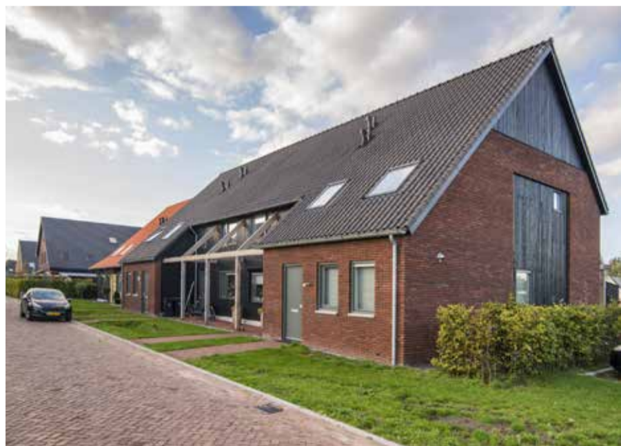
Schuurwoningen op het erf
