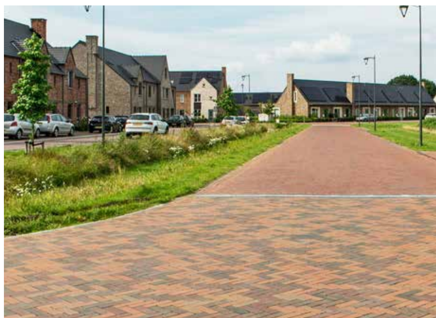
Hoofdontsluiting in een groene omgeving, uitgevoerd in elementenverharding van gebakken materiaal
