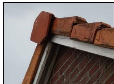
Figuur 8. Nokvorst en kantpannen van het woonhuis.
