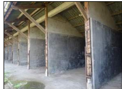
Figuur 5. Voorzijde van de kapschuur.
