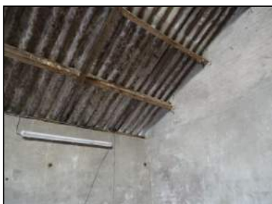
Figuur 6. Binnenzijde van de bedaking in de schuur.
