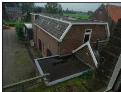
Figuur 4. Maalderij met plat dak en gedeelte dakpannen.
