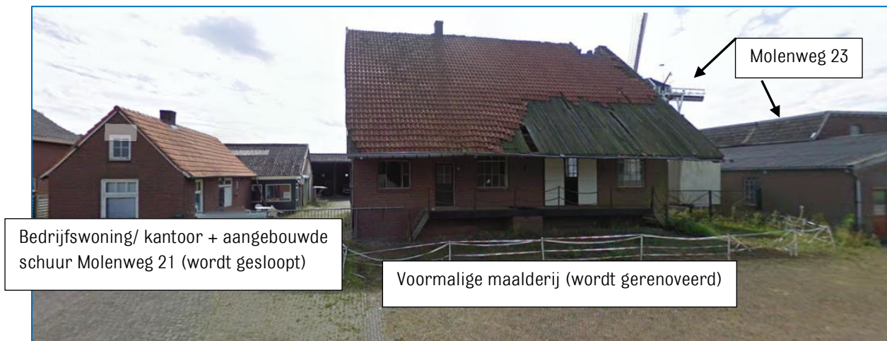
Figuur 10: huidige situatie Molenweg 21 met links voormalige bedrijfswoning/ kantoor en in midden voormalige maalderij
