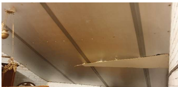
Foto 3: Dichtgemaakt gat in isolatieplaat
