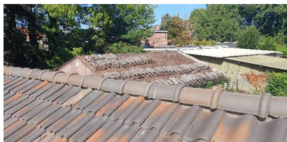
Foto 10: Pannendak en achterste schuur
