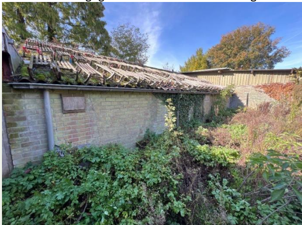
Figuur 6: Dak(goot) bebouwing
