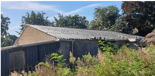
Foto 6: Achterzijde voorste schuur
