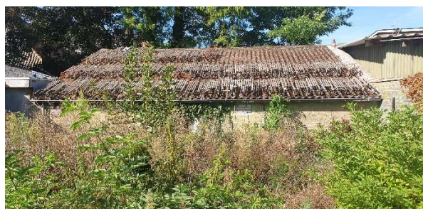
Foto 2: Schuur met golfplaten
