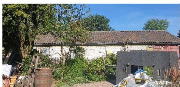
Foto 4: Erf en voorste schuur
