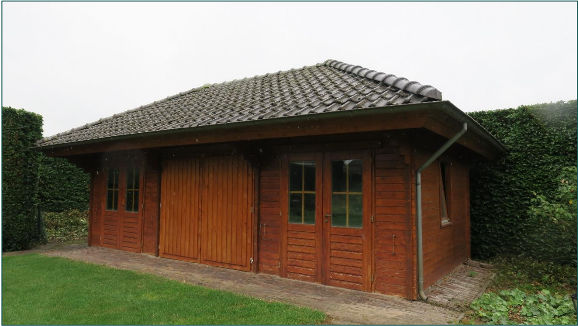
Figuur 1.3 De tuinschuur zal gesloopt worden ten behoeve van de beoogde ontwikkeling.
