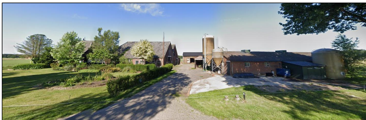
Figuur 3: zicht op planlocatie vanaf Den Dam.
