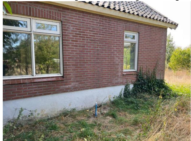
Figuur 14: Vml. locatie HBO-tank
